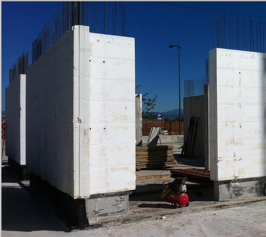
Dettaglio isolamento cappotto muri
