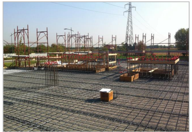
Dettaglio armatura solaio a piastra
