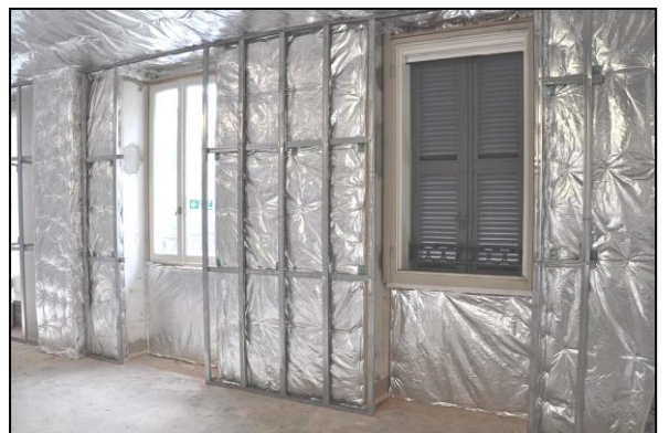
Dettaglio isolante a basso spessore
