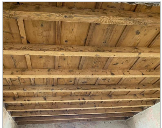
Dettaglio solaio in legno
