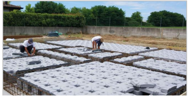
Dettaglio vespaio iso-aerato e fondazioni
